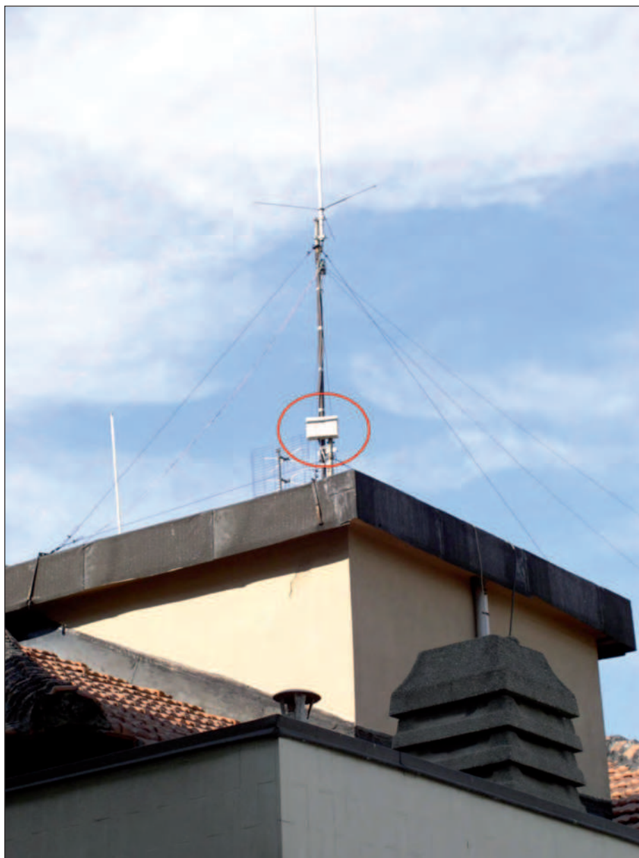
Figura 2: l'antenna nel cerchietto rosso è una doppia biquad.
